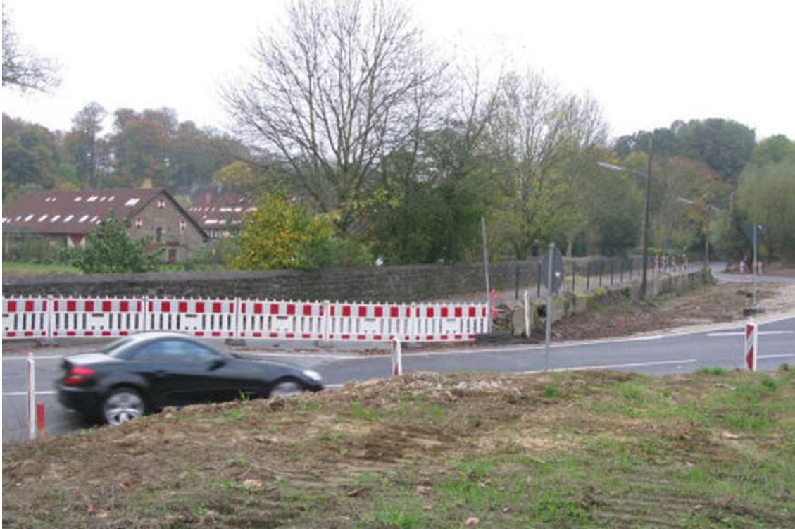
Die ersten Baumaßnahmen an der Schattbachstraße sorgen für Brachland vor den Toren des „Haus Laer“. Bald wird hier die A44 entlang laufen. (Foto: Nickel)
