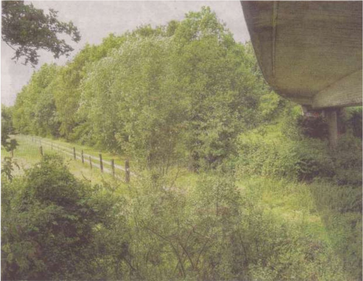
Über die Brücke braust schon der Verkehr von der Wittener Straße in Richtung A 44. Das Grün darunter muss auch bald weichen. Fotos: WAZ
