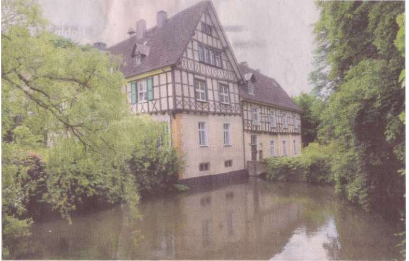
Das Rittergut Haus Laer: Wenn diese Gräfte trocken fällt, drohen die über 1000 Jahre alten Balken zu verfaulen. Foto: Karl Gatzmanga
