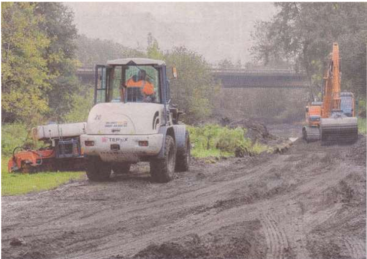
Seit Anfang der Woche wühlen sich schwere Baufahrzeuge östlich der Schattbachstraße durch den Grünzug. Foto: Karl Gatzmanga
