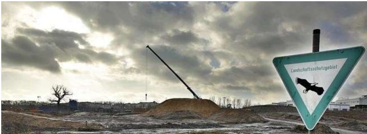
Das Rodungsgebiet Markstraße / Höfstraße, zur Vorbereitung für die zweite Autobahnbrücke. und ein Regenrückhaltebecken. Foto: Dietmar Wäsche
