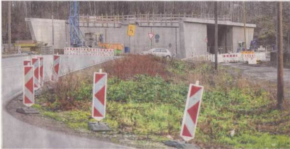
Die fast fertiggestellte Autobahnbrücke Schattbachstraße in Höhe Höfstraße.
