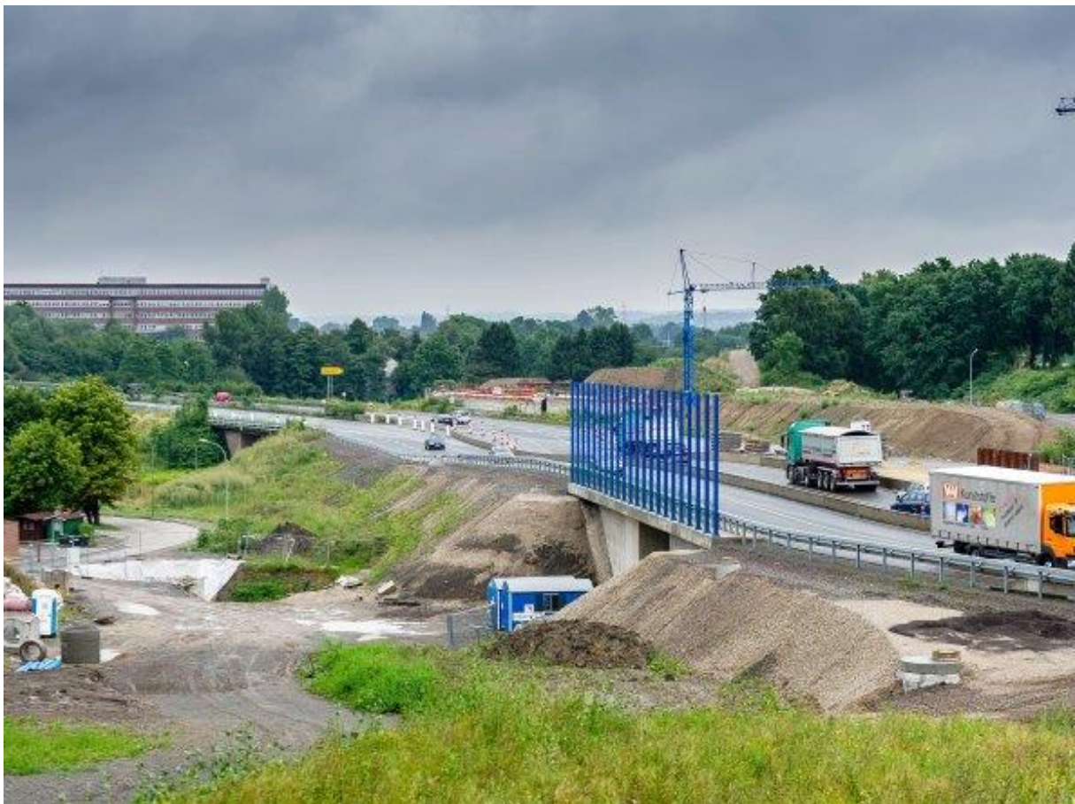
Autobahnbau Die neue Querspange wird erst Ende 2019 fertig
