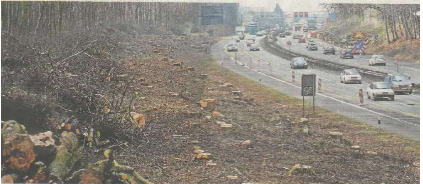
Es wird weiter gebaut auf der Autobahn 40: Zahlreiche Bäume mussten der Erweiterung bereits weichen. Foto Walter
