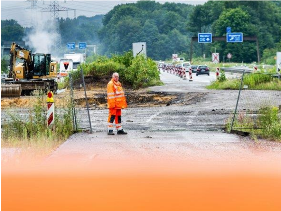
Autobahn 448 Freigabe von Querspangen-Teilstück verzögert sich erneut
