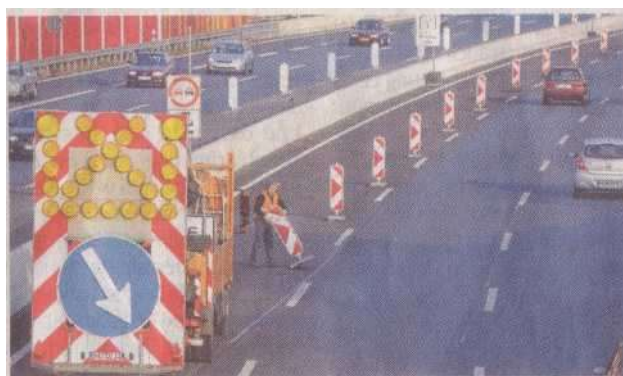
Die letzten Aufräumarbeiten...
