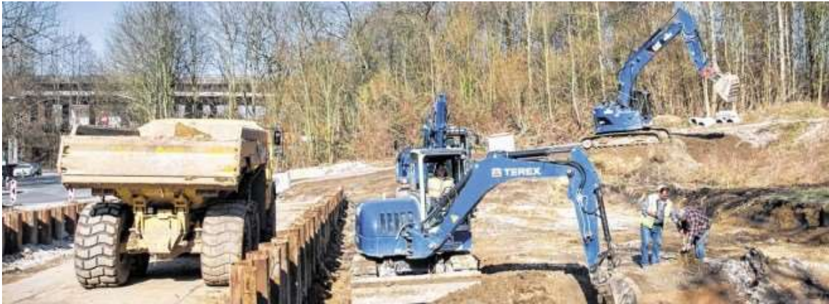
An der "Querspangen"-Baustelle Schattbachstraße graben Bagger, aus denen Diesel abgezapft worden ist, am Dienstag, den 05. März 2013 in Bochum. Foto: Ingo Otto / WAZ FotoPoolFoto: INGO OTTO
