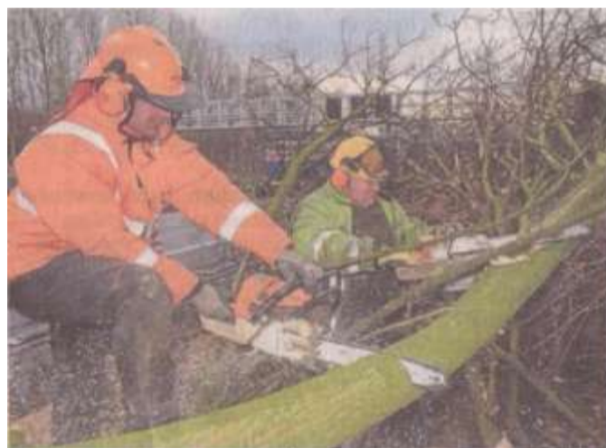
Baumfällarbeiten für den sechsspurigen Ausbau der A 40 - ein Teil der sogenannten „Bochumer Lösung“. RN-Foto Archiv
