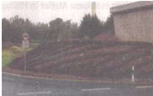
Die Hänge an der Querspange wurden mit Strängen aus gebundenen kleinen Ästen befestigt. Foto: B.Ki
